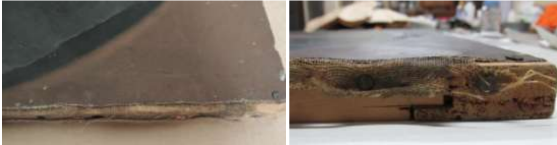
Detalle del estado borde de tensión anclado al listón inferior. A la izquierda mirada desde arriba a la derecha mirada lateral.
