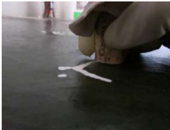
Nivelación de resanes utilizando un corcho
