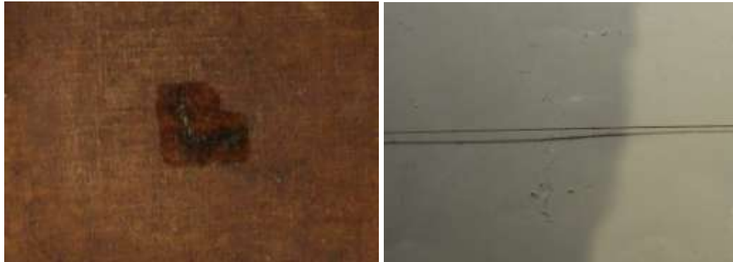
Preparación de soporte e hilo con Beva 371 en deterioro bajo el parche N°6.
