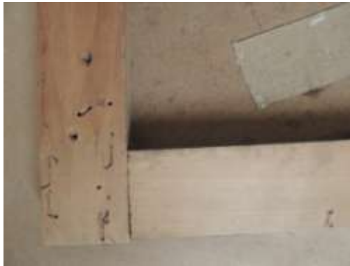
Ataque por Xilófagos en extremo inferior del listón Izquierdo
