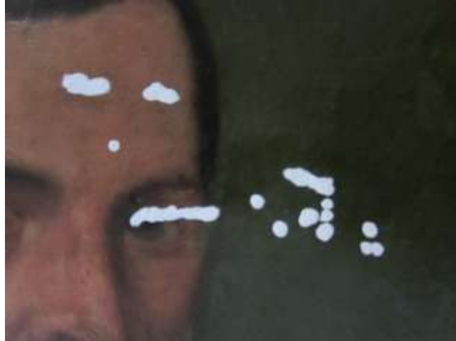
Detalle de resanes sin nivelar
