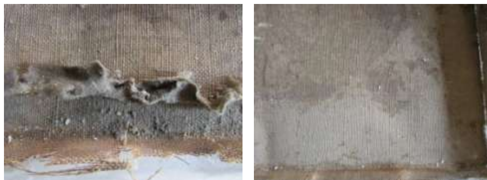
A la izquierda detalle terrario encontrado bajo el listón inferior después de retirar bastidor, a la derecha estado de la tela después de limpieza de terrario.
