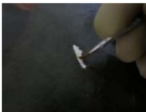
Detalle de aplicación de goma laca sobre resane.
