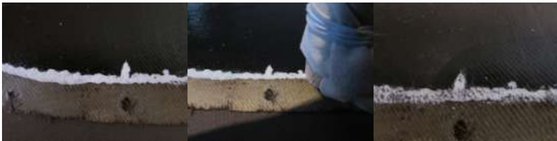
Ejemplo de proceso de nivelación resanes pequeños.
